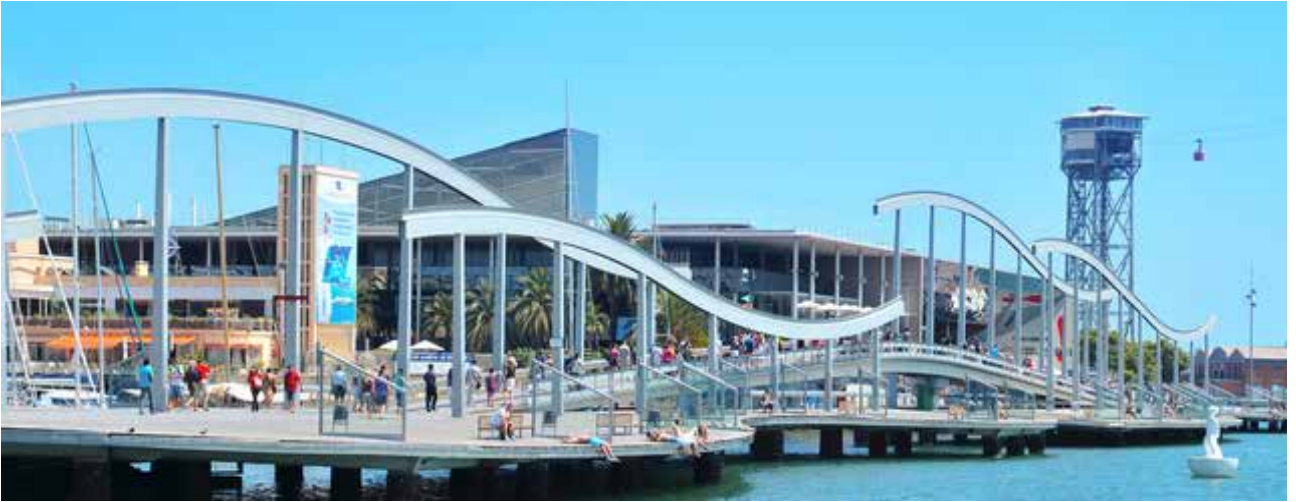
G2 Kapısı için örnek: Akvaryum Binası, Barselona.
